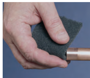
Rohrende blank machen
