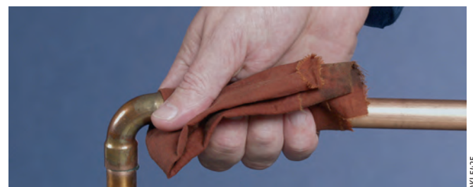
Flussmittelreste entfernen
