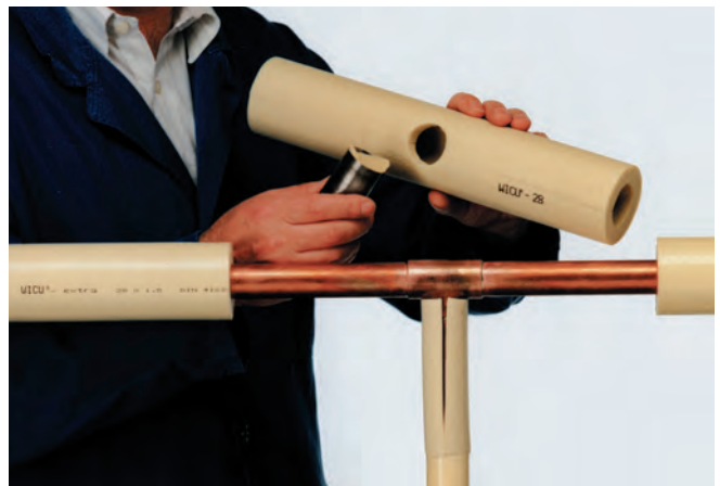
Zuschneiden und Aufbringen eines Formteils
